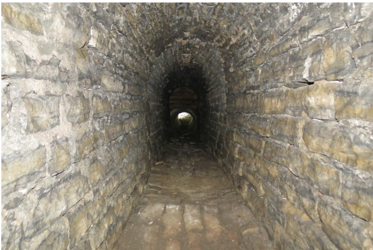
Průzkum propustku pod silnicí do Černčic ve spolupráci s náchodským archeologem
